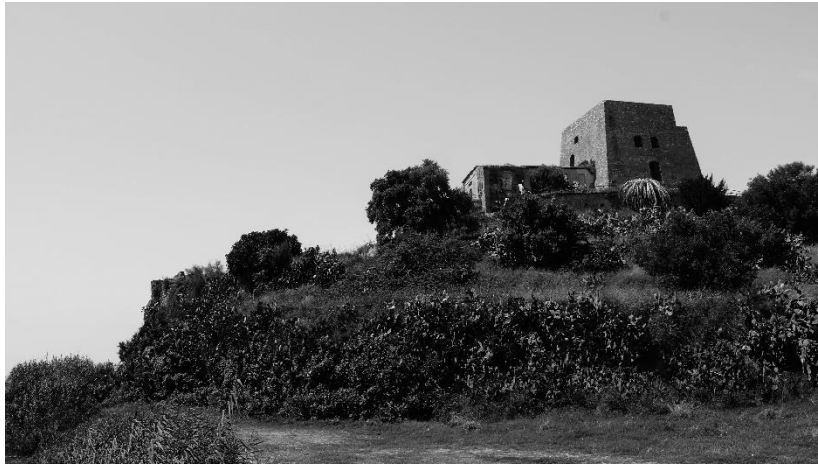
Foto: La torre vista dal lato Sud
